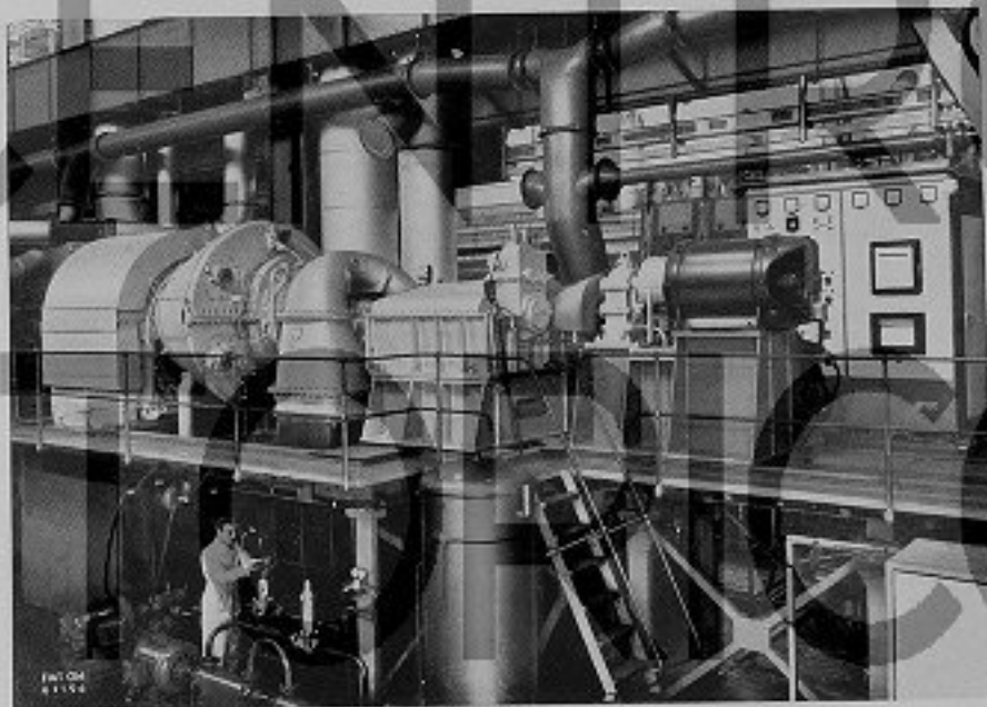
Fig. 6 - Turbina FIAT TG 500 sul banco di prova. La semplicità costruttiva di questa macchina si accompagna alla massima sicurezza di funzionamento.
