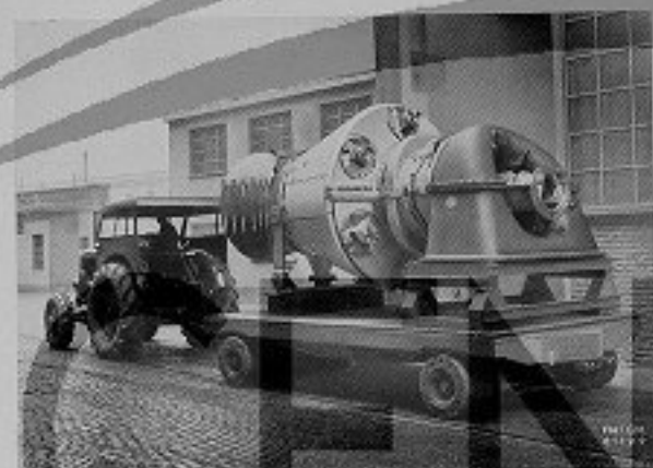
Fig. 11 - Il trasporto della turbina interamente montata può essere effettuato con mezzi di normale dotazione, date le limitazioni di peso e di ingombro.
